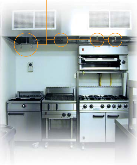
Una instalación ANSUL R-102 típica con boquillas de descarga colocadas en una campana
